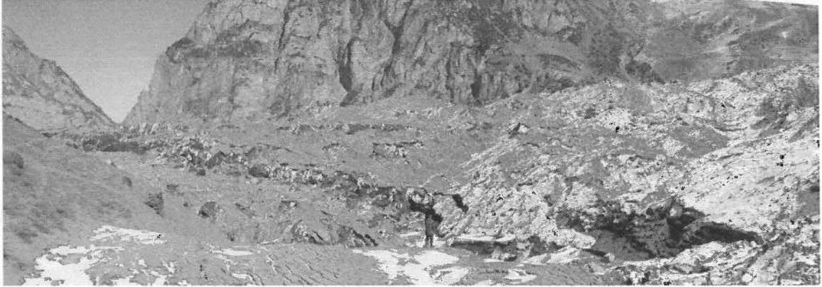
Рис. 7. Оползень в Кармадонском ущелье (Северная Осетия)
