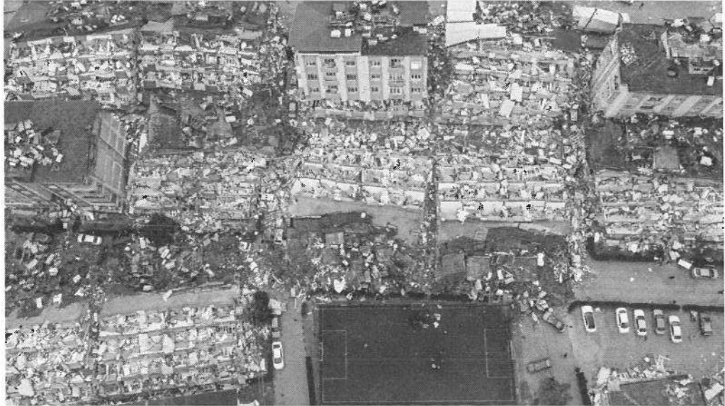
Рис. 3. Последствия землетрясения в Турции в 2023 г.
